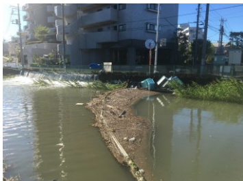
▲ 溢水した水が住宅街から菖蒲川へ
